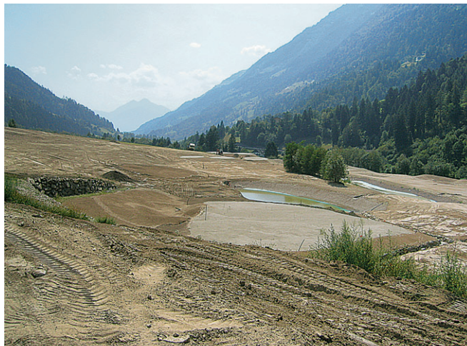
In fase di movimenti di terra, muretti in pietra sono utilizzati per compensare dislivelli tra le buche. Sopra, la buca 17 del Passiria GC in costruzione. Sotto, la stessa buca completata.
